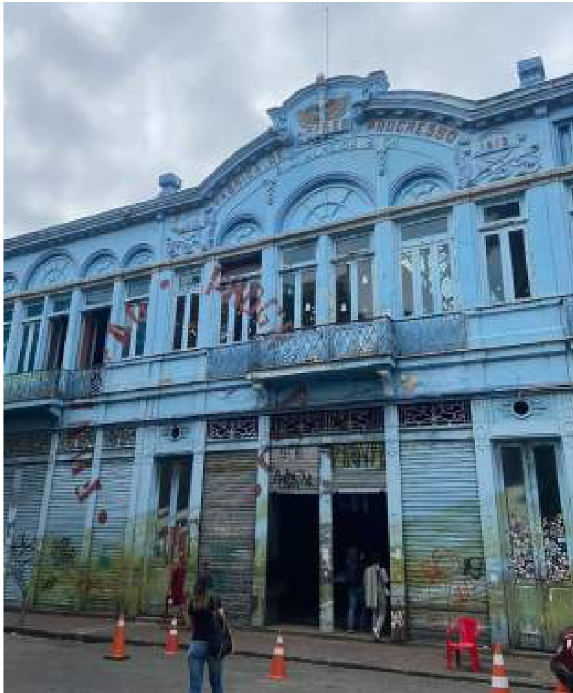
Figure 1 – Current façade of Fundação Progresso
