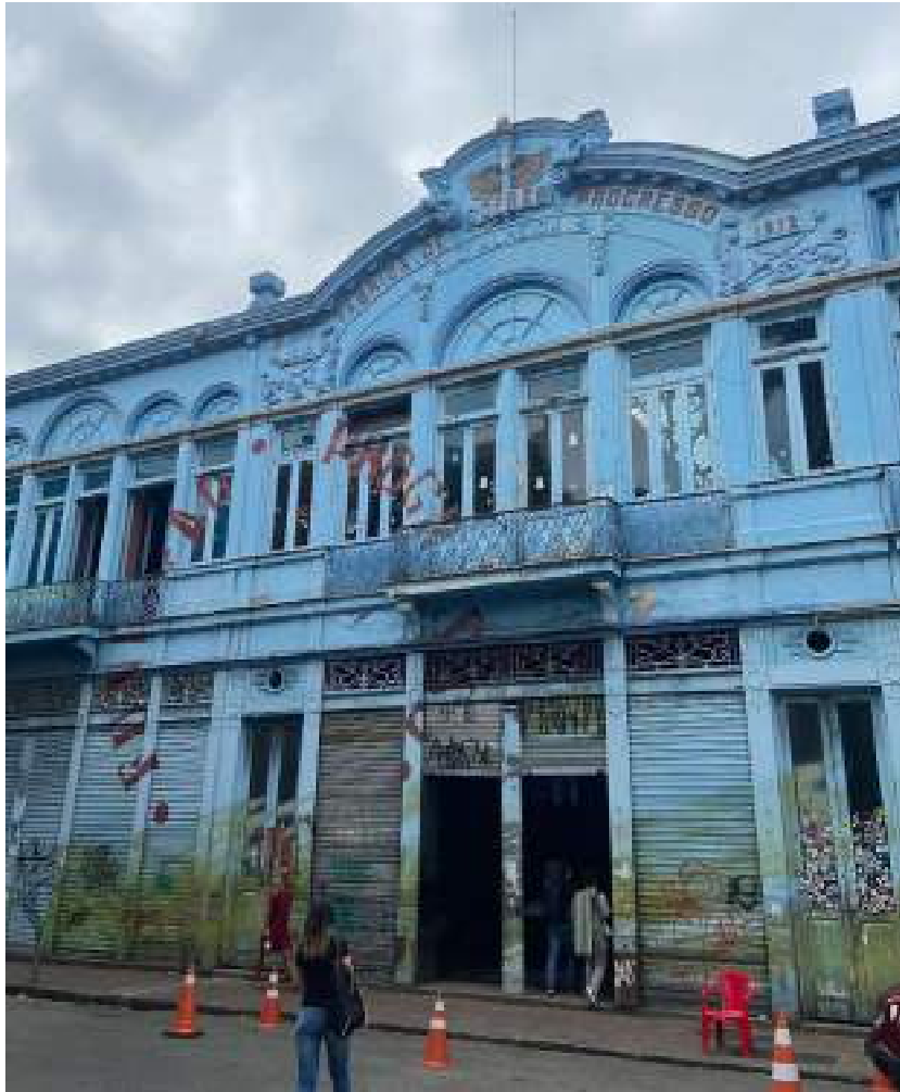
Figura 1 – Fachada atual da Fundação Progresso
