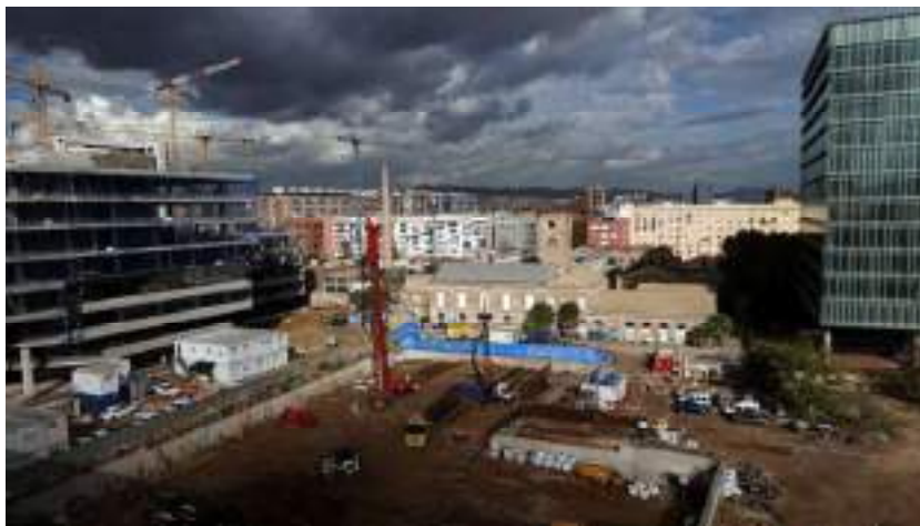
Figura 4 – Conjunto de Can Ricart en las obras de transformación
