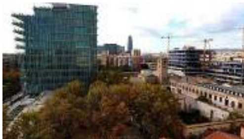
Figura 8 – Las naves de Can Ricart rodeadas de nuevas construcciones
